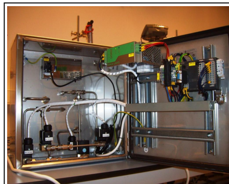
Binnenin is de mini-PLC te zien
